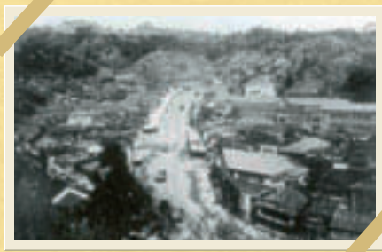
昭和25年頃の国道16号。交通量はまだ少ない。
